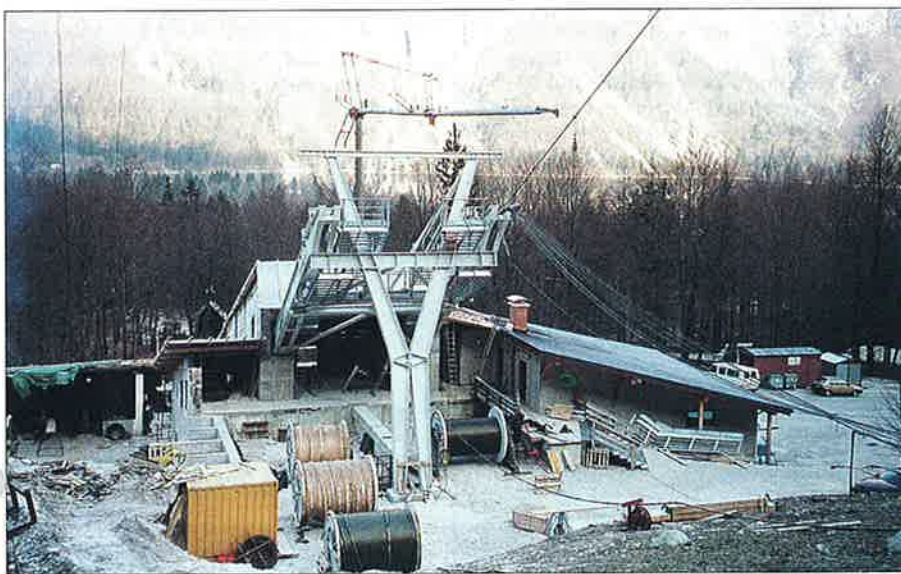
Na gradbišču nove nihalne žičnice na Vogel.
