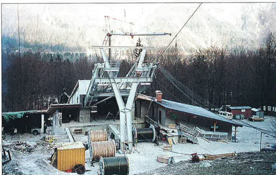
Na gradbišču nove nihalne žičnice na Vogel.
