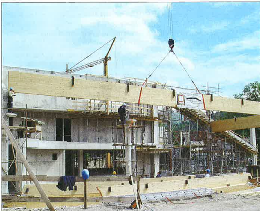
Vgradili so enega najdaljših lesenih lepljenih nosilcev v Sloveniji.
